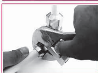
ثابت شدن لوله، بین حلقه و ماسوره در اتصال دنده ای
