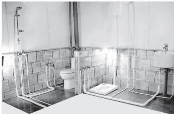
نحوه اجرای سیستم لوله کشی در سرویس توالت و حمام
