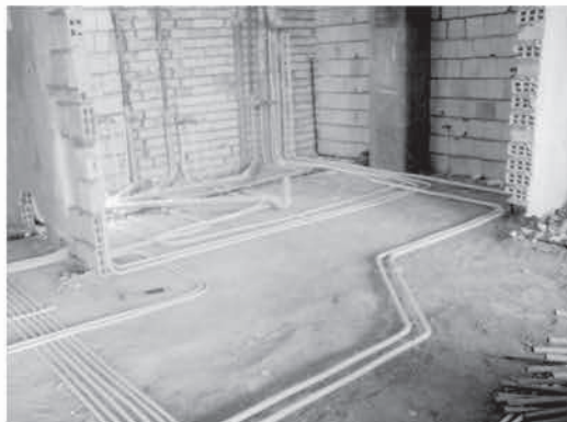
نحوه اجرای سیستم لوله کشی در فضای کف اتاق ها
