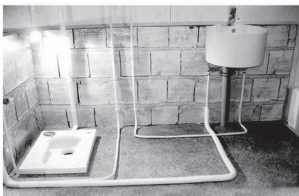
نحوه اجرای سیستم لوله کشی در سرویس توالت
