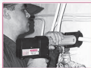
ثابت شدن لوله، بین حلقه و ماسوره در اتصال پرسى
